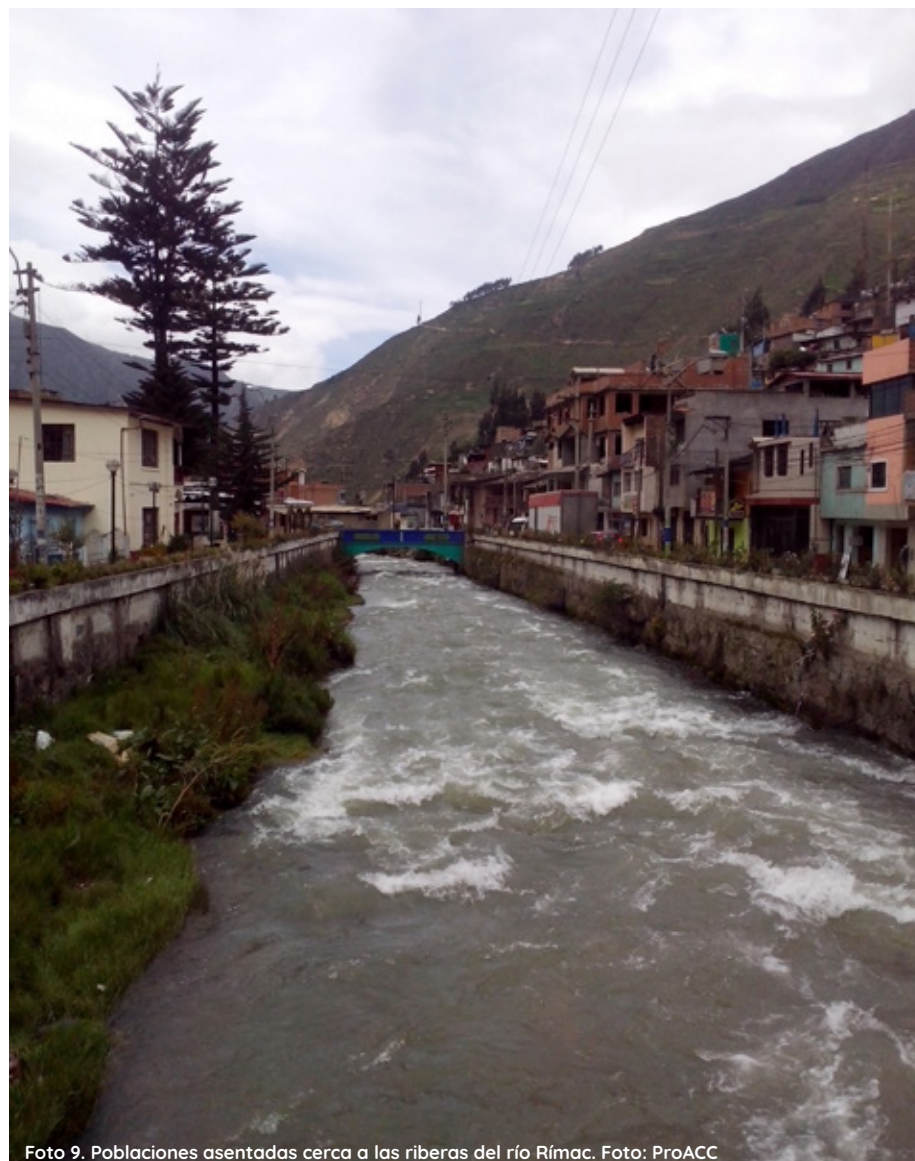
Foto 9. Poblaciones asentadas cerca a las riberas del río Rímac. Foto: ProACC
