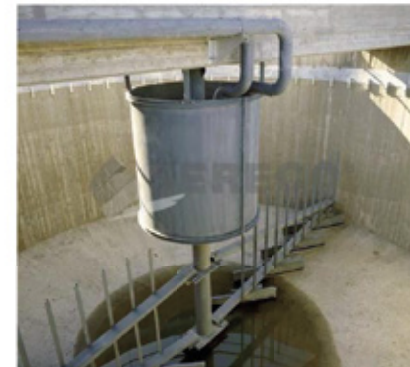
Figura 8. Vista interior de espesador
