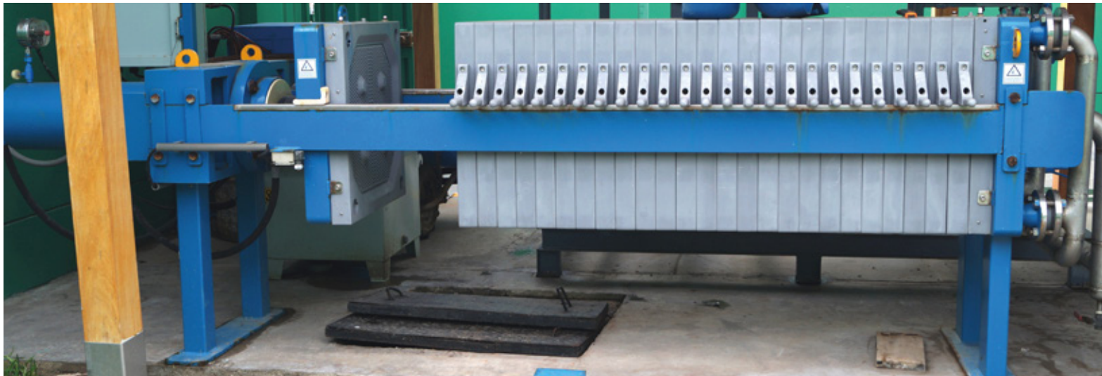
Figura 11. Filtro Prensa de Sistema de Tratamiento de Lodos
