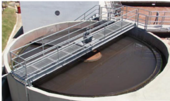
Figura 7. Espesador de lodos
