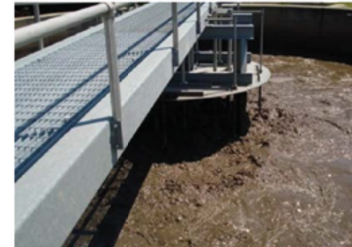
Figura 3. Digestor aerobio de lodos
