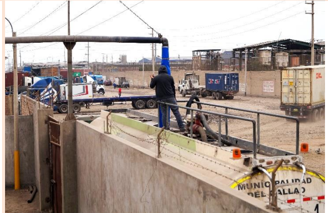
Abastecimiento de agua tratada de la PTAR Oquendo, mediante surtidores, para cisternas de la Municipalidad Provincial del Callao
