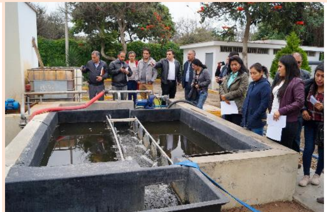
Representantes municipales observan sedimentadores de PTAR Juan Pablo II
