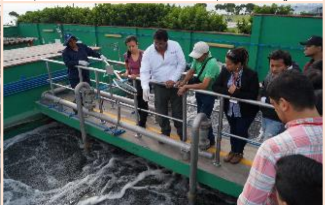
Reactor de lodos activados de lecho móvil (MBBR) de la PTAR
